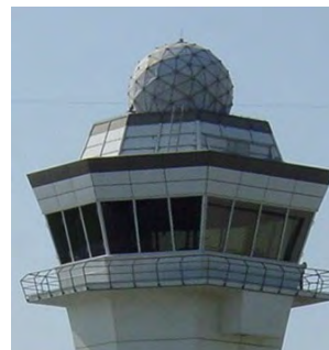
管制塔に設置された ASDE アンテナ
